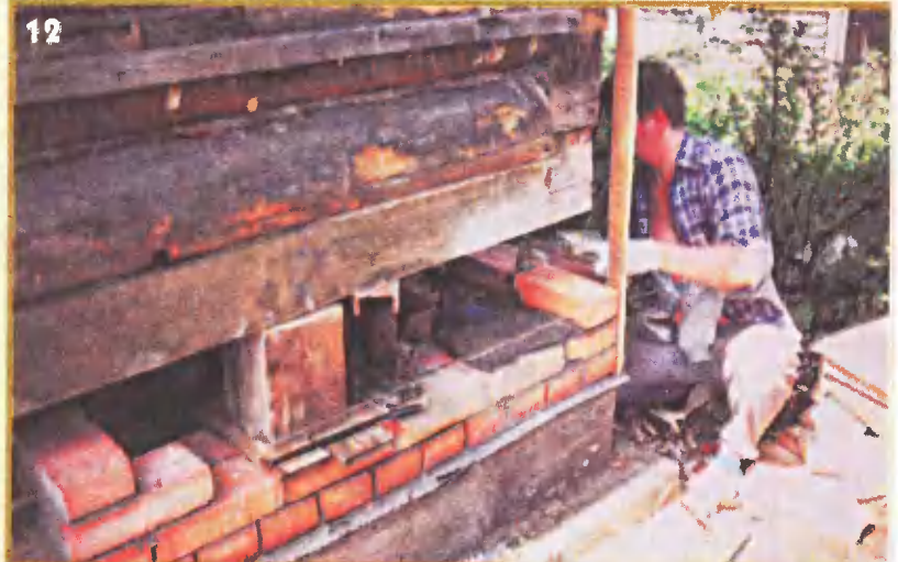
Дом поставлен на прочную опору (бетонный столбик с кладкой в два кирпича). Теперь можно приступать к изготовлению ленты фундамента.
