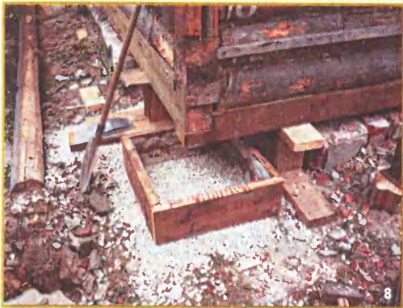
Бетонную плиту под угол дома отливали на гравийной подушке толщиной 10...15 см.
