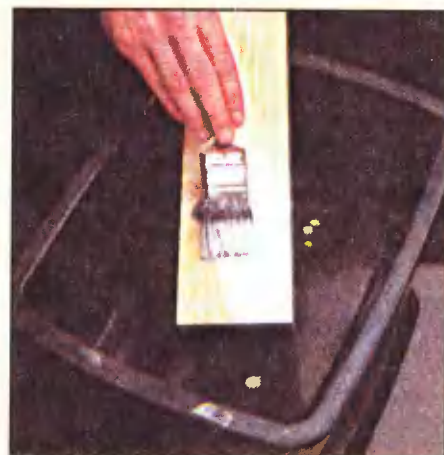
Перед нанесением лака доски следует основательно покрыть слоем защитного грунта.
