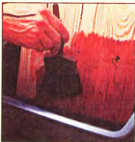
Открытые торцевые кромки досок лучше всего покрыть, погружая в состав.
