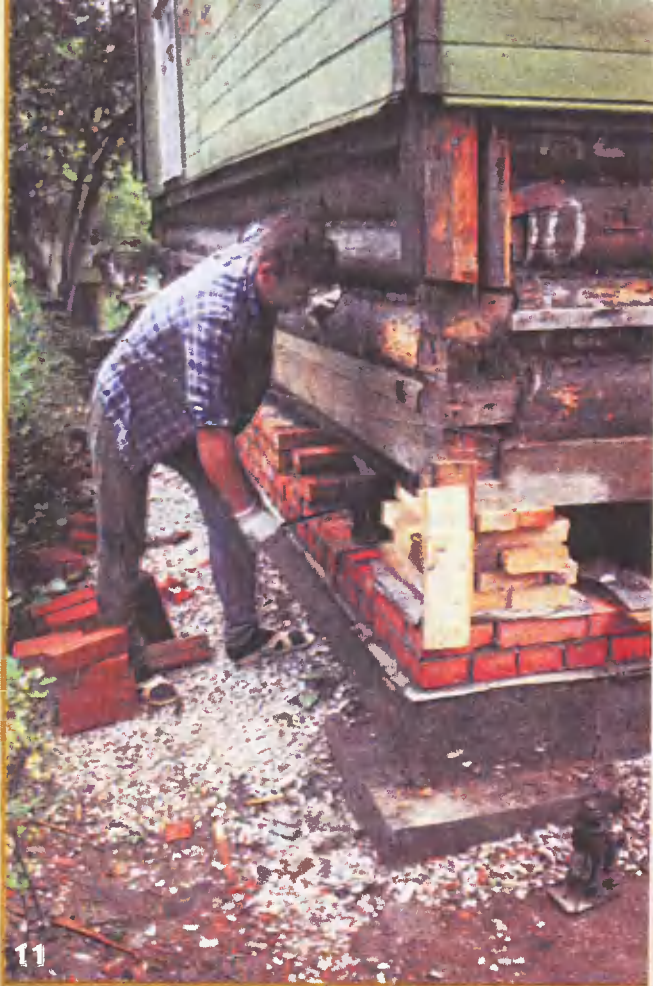
Опалубка для отливки бетонного столбика. К началу этой работы плита должна «схватиться», на что нужно около двух дней.
